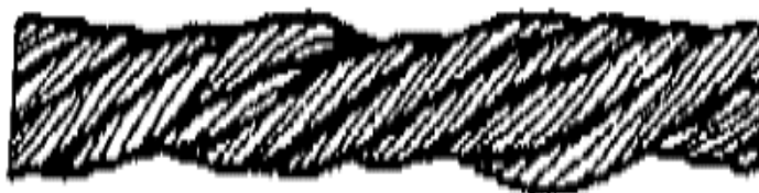
Рис.7. Местное уменьшение диаметра каната на месте разрушения органического сердечника
